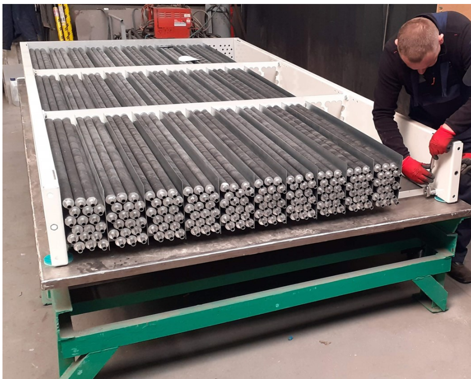
Chłodnica w trakcie montażu pakietu rur
